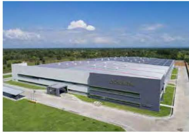
▲工場全体 (昼間)
